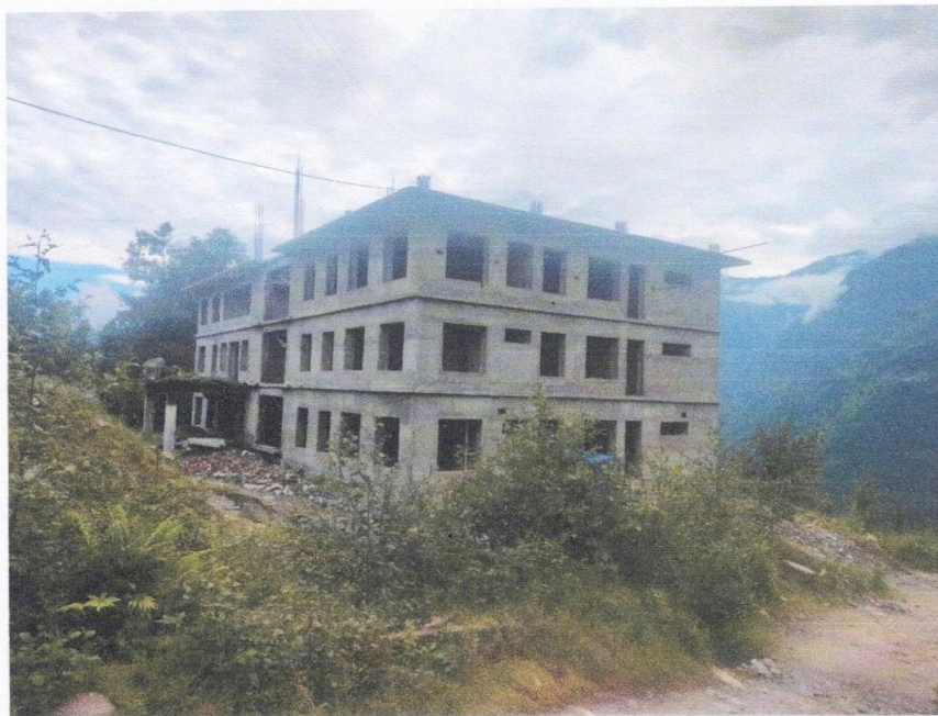
निर्माणाधिन गाउँपालिका भवन वडा नं. ४, थलड
